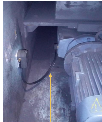
Beacons AsystemSentinel in situ – su sonda inteligente que permite la instalación en espacios reducidos
