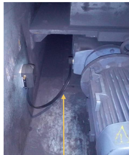
AsystemSentinel in situ - la loro sonda intelligente permette l'installazione negli spazi ristretti
